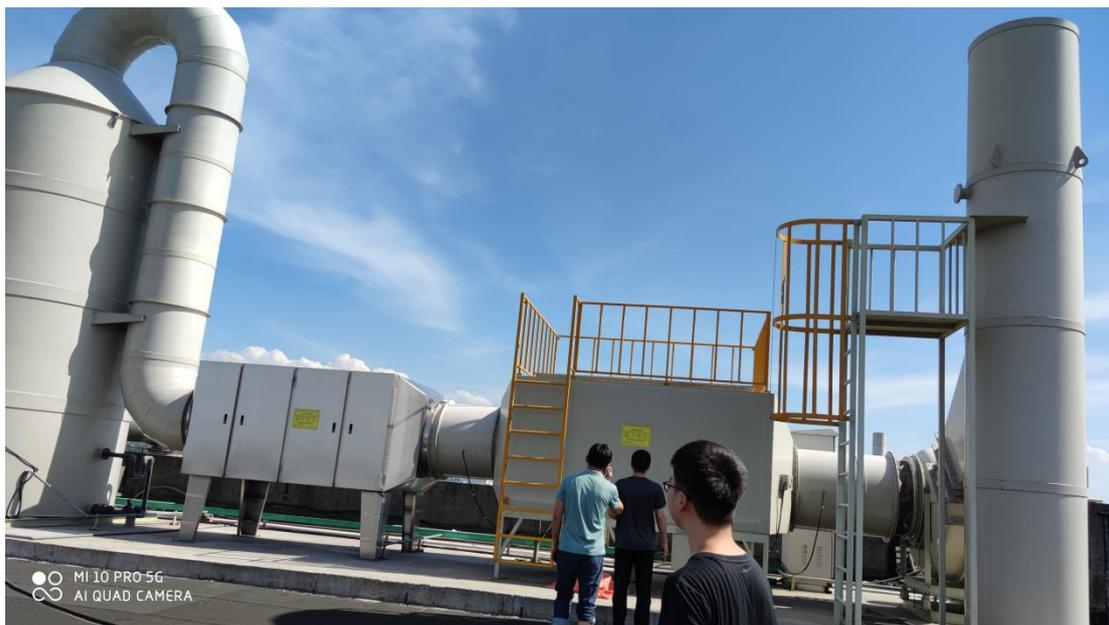
图 4-2 碱洗堆料塔+光氧催化+活性炭吸附设施及 DA002 排气筒
