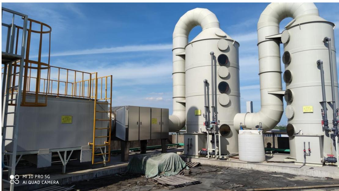
图 4-3 旋流板塔+碱洗堆料塔+光氧催化+活性炭设施及 DA003 排气筒
