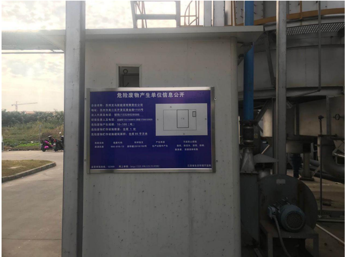
图4-1 本项目危废仓库
