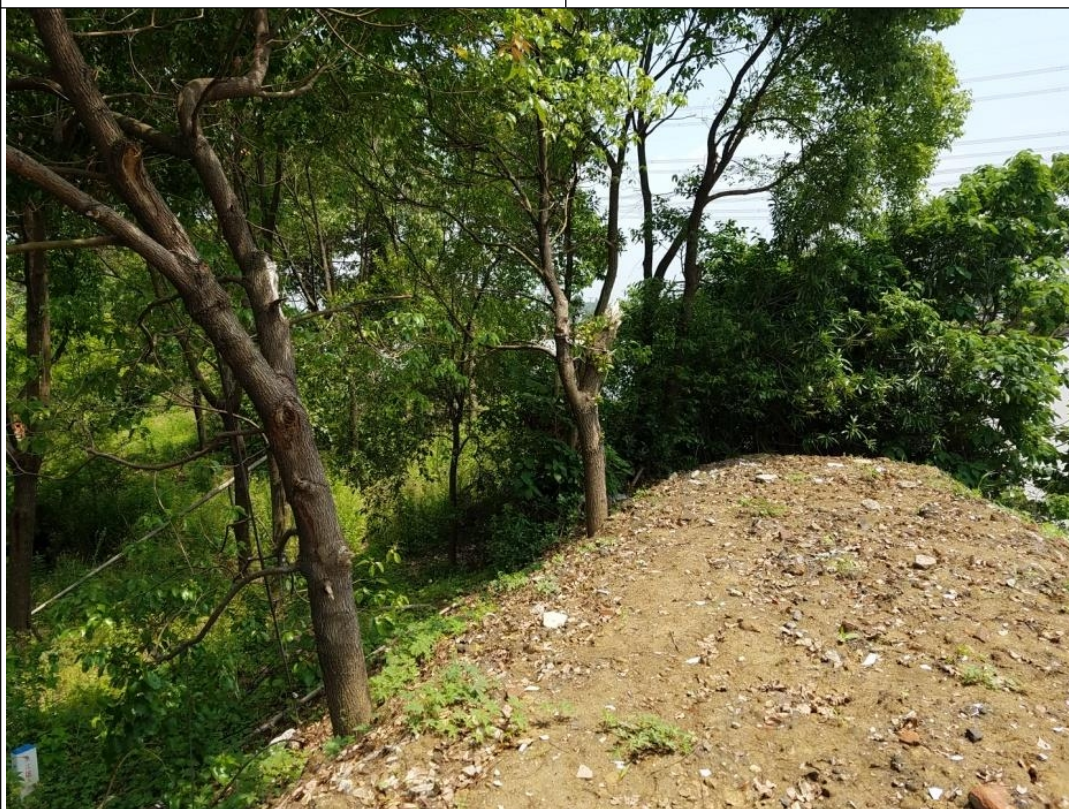
图 3-5 西港、澜溪塘现状堤防相接处
