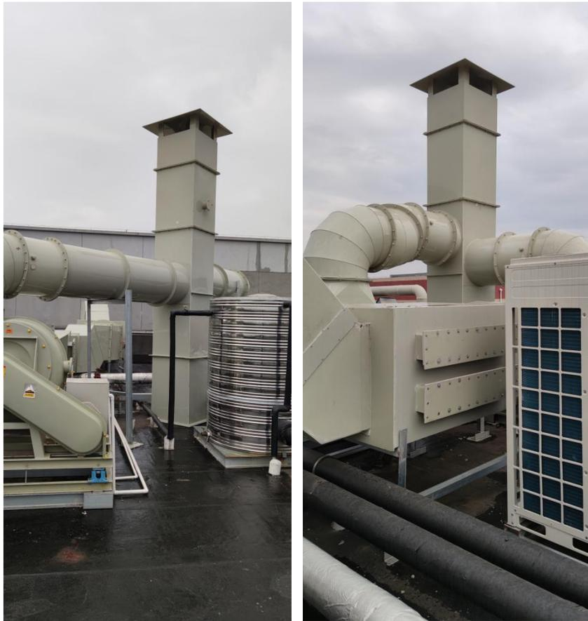
图 3-7 废气处理设施及排气筒
