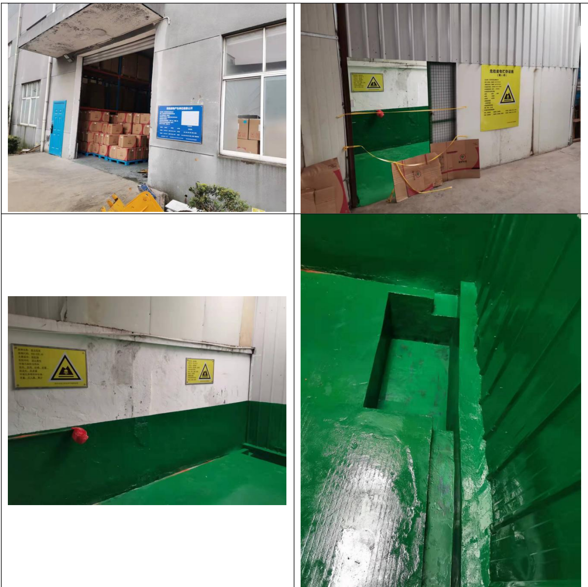
图 3-8 危险废物仓库
