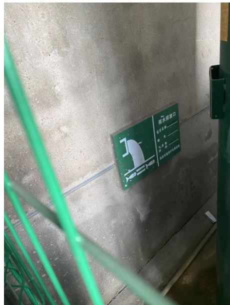
图 3-3 项目污水排放口
