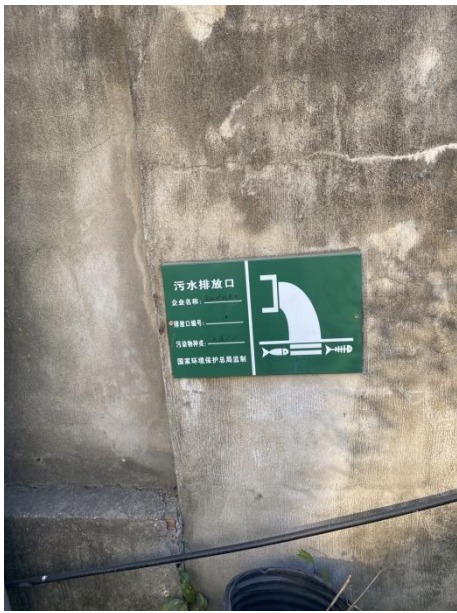
图 3-2 项目污水排放口
