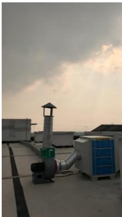
图 3-1 现场两级活性炭装置及排气筒照片
