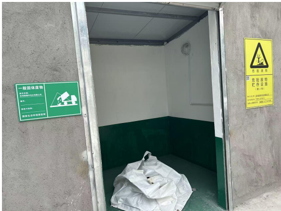
危废暂存间正门及贮存设施标志牌
