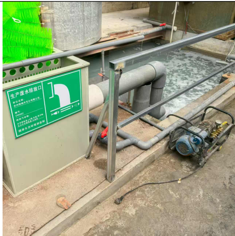
生产废水排放口
