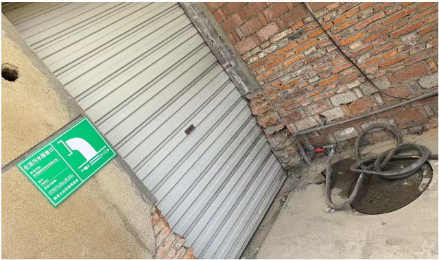
生活污水排放口
