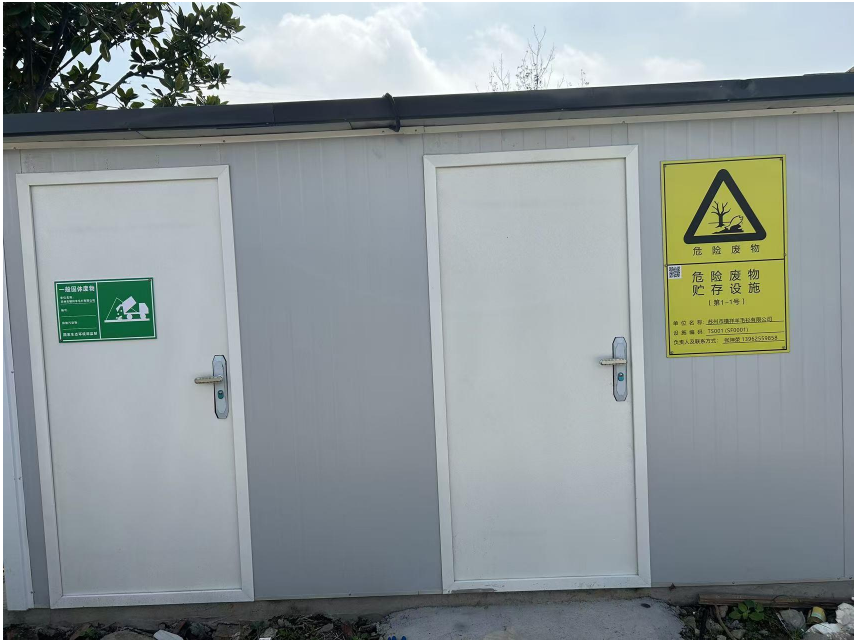
危废暂存间正门及贮存设施标志牌
