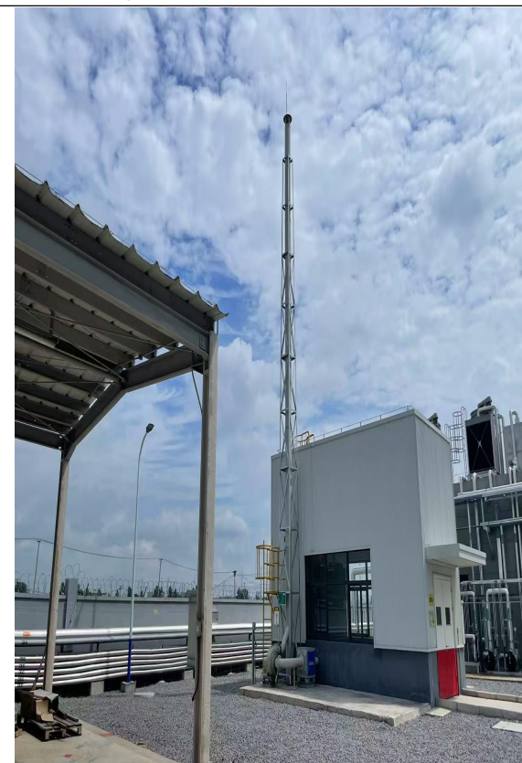
FQ-10 排气筒 15 米 (DA011)
