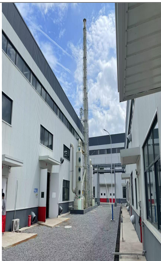
FQ-01 排气筒 25 米 (DA006)
