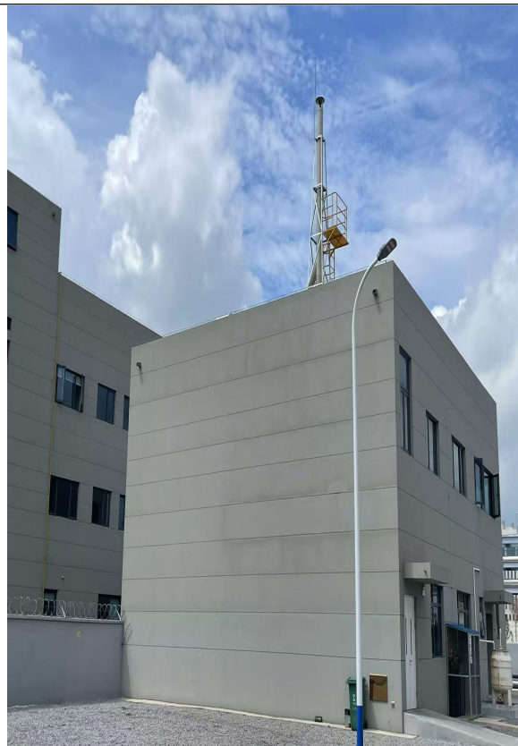
FQ-09 排气筒 15 米 (DA008)
