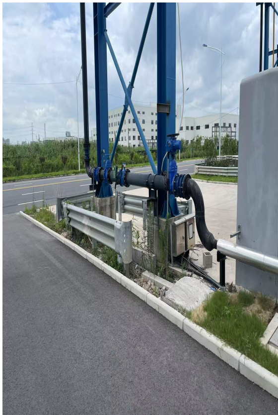
污水接管排口照片
