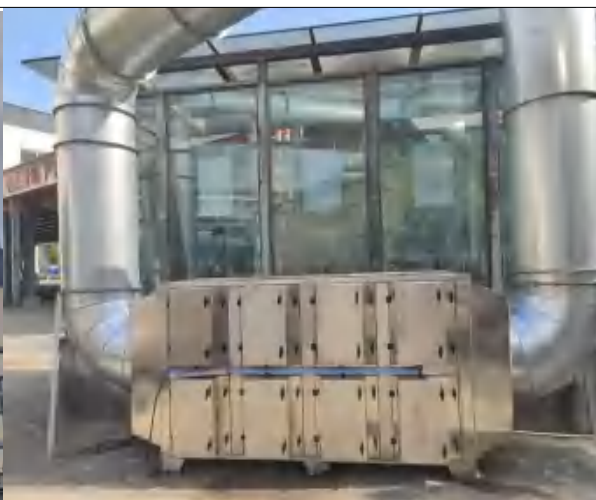
废气处理装置（水喷淋+高压静电净化）
