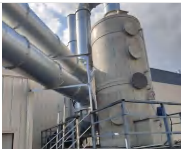
废气处理装置（水喷淋+高压静电净化）
