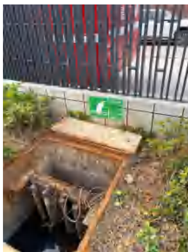
雨污排口标识牌
