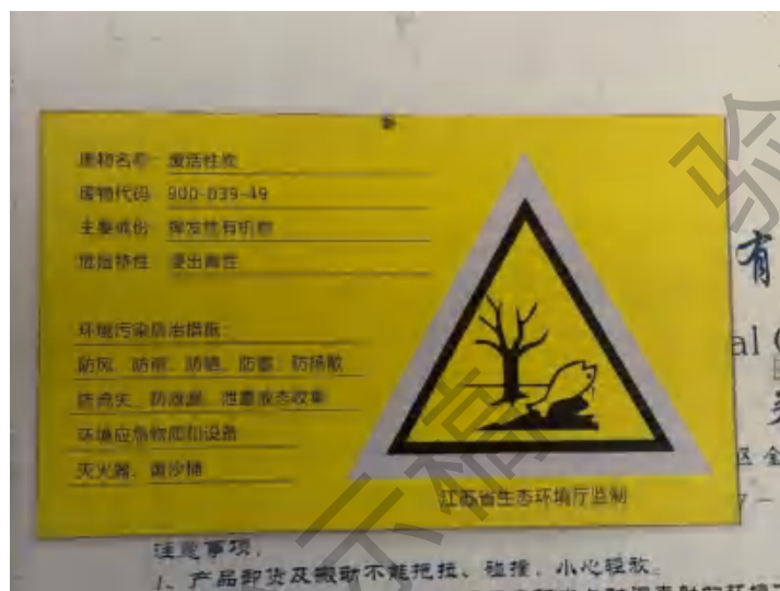
危险废物环保标识牌（废活性炭）
