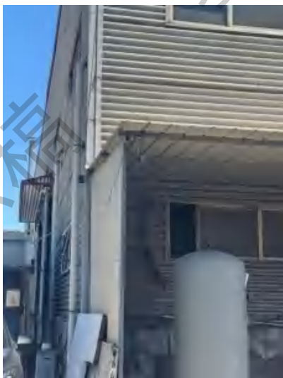
危险废物贮存设施外部视频监控
