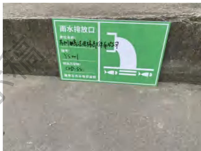
雨水排口环保标识牌
