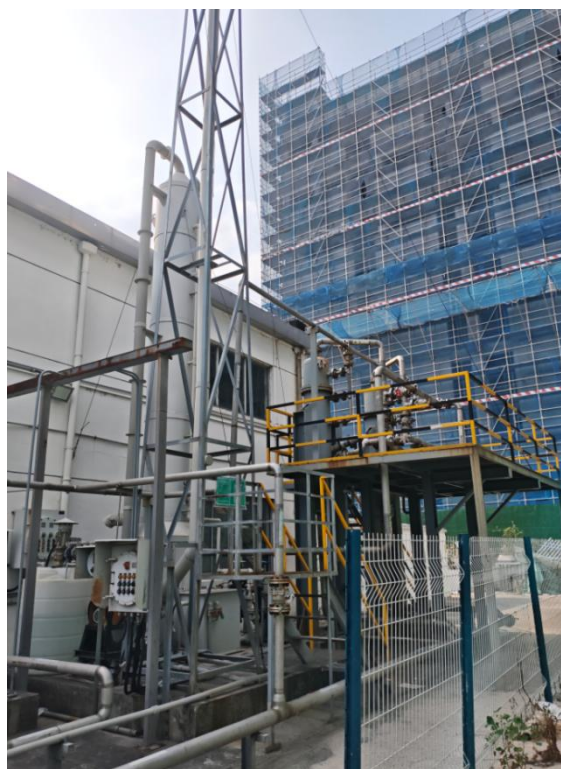
图 4.1.2-2 废气三级喷淋系统（DA001）
