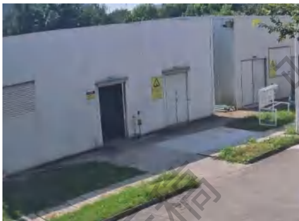
危险废物贮存设施外部视频监控
