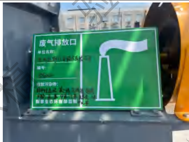
废气排放口 DA002 环保标识牌
