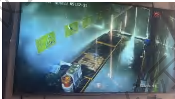
危险废物贮存设施内部视频监控
