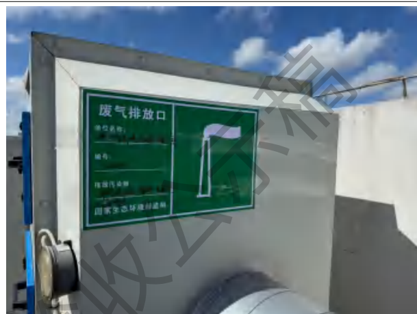
废气排放口 DA003 环保标识牌
